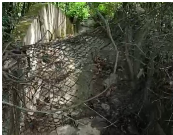
图 6.2-2 垃圾填埋场渗滤液处理站东侧冲沟
