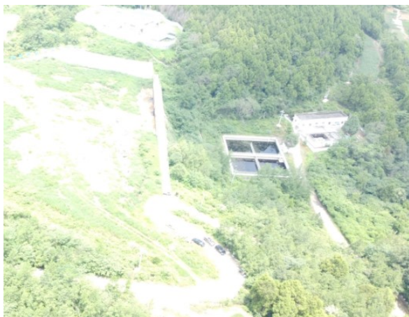
图 6.2-1 垃圾填埋场渗滤液处理站
