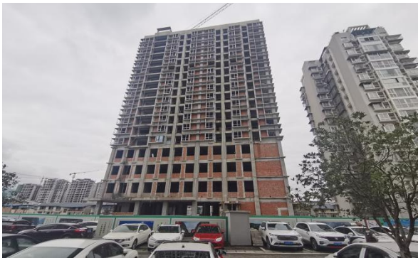
科教综合楼（在建）
