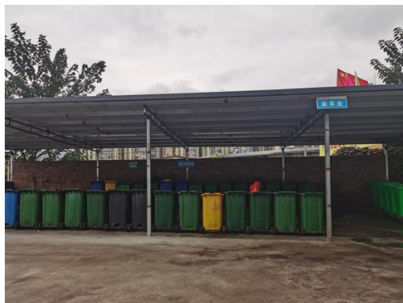
生活垃圾暂存间（外）
