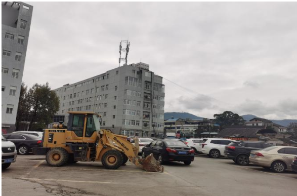
第一住院大楼
