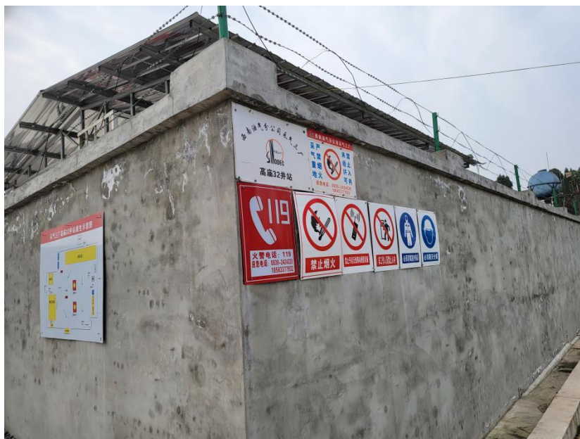
图 3.2-1 高庙 32 增压站现场图
